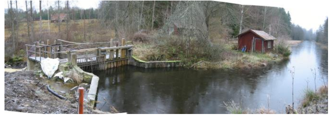
Här är utloppet från Näshultasjön. Dammen ligger ca 13 meter över turbinen. Dammluckorna regleras manuellt. Foto Tord D
