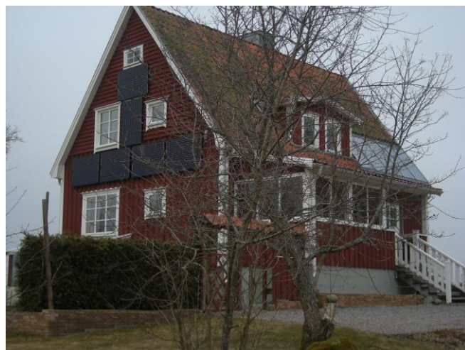
På taket sitter solvärmepanelerna och på gaveln de nya solcellerna. Foto Roland Gustavsson
