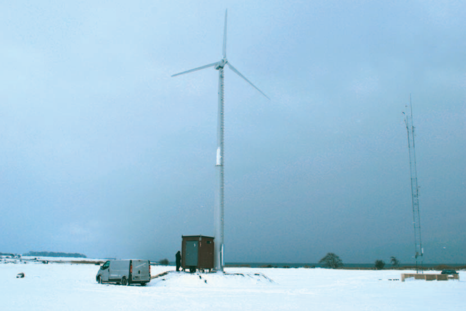
Detta vindkraftverk på 20 kW från Morhic provas nu på Öland. Till höger skimtar vindmätmasten.
