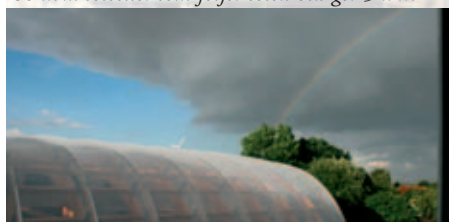
"Envelope-hus" Växthus av dubbelväggig plastfolie. Övertryck på luften mellan folierna spänner upp huset.
