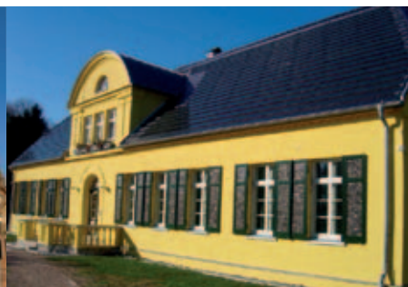
Solceller monterade på fönsterluckor.
