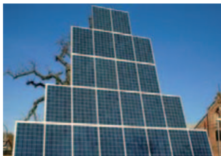
60 kvm solceller som följer solen och ger 5 kW.
