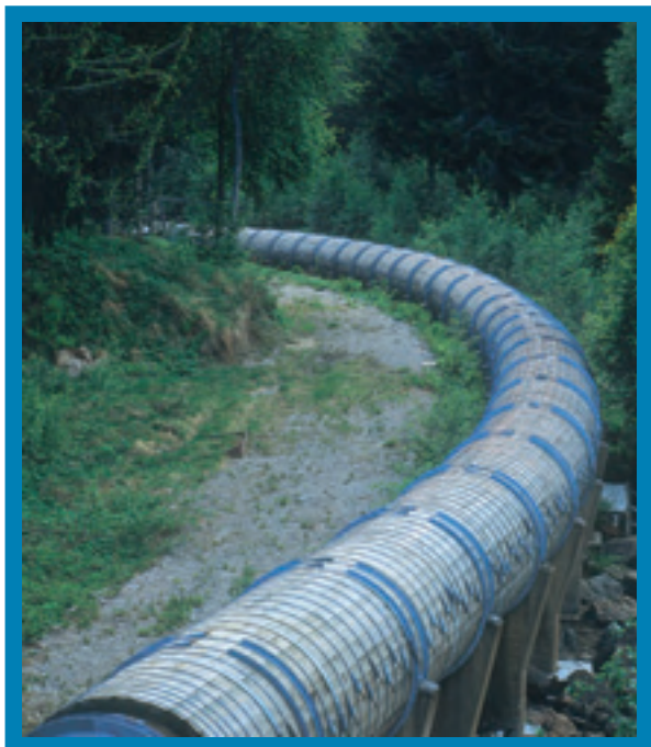
Kungfors kraftstation, Sandviken, turbinledning på fundament.
