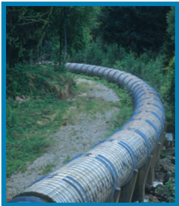
Kungfors kraftstation, Sandviken, turbinledning på fundament.
