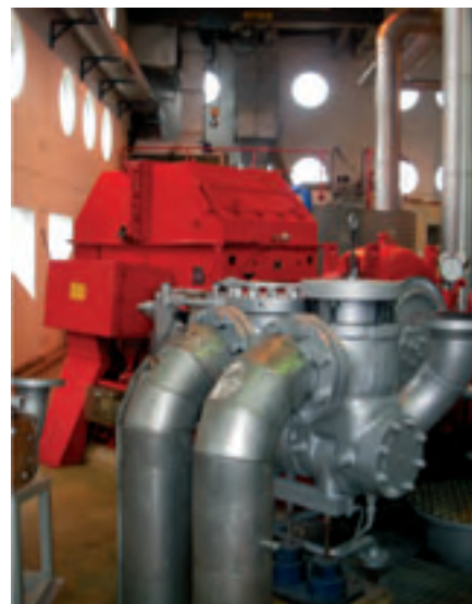
Det finns fem stora geotermiska kraftverk på Island.
