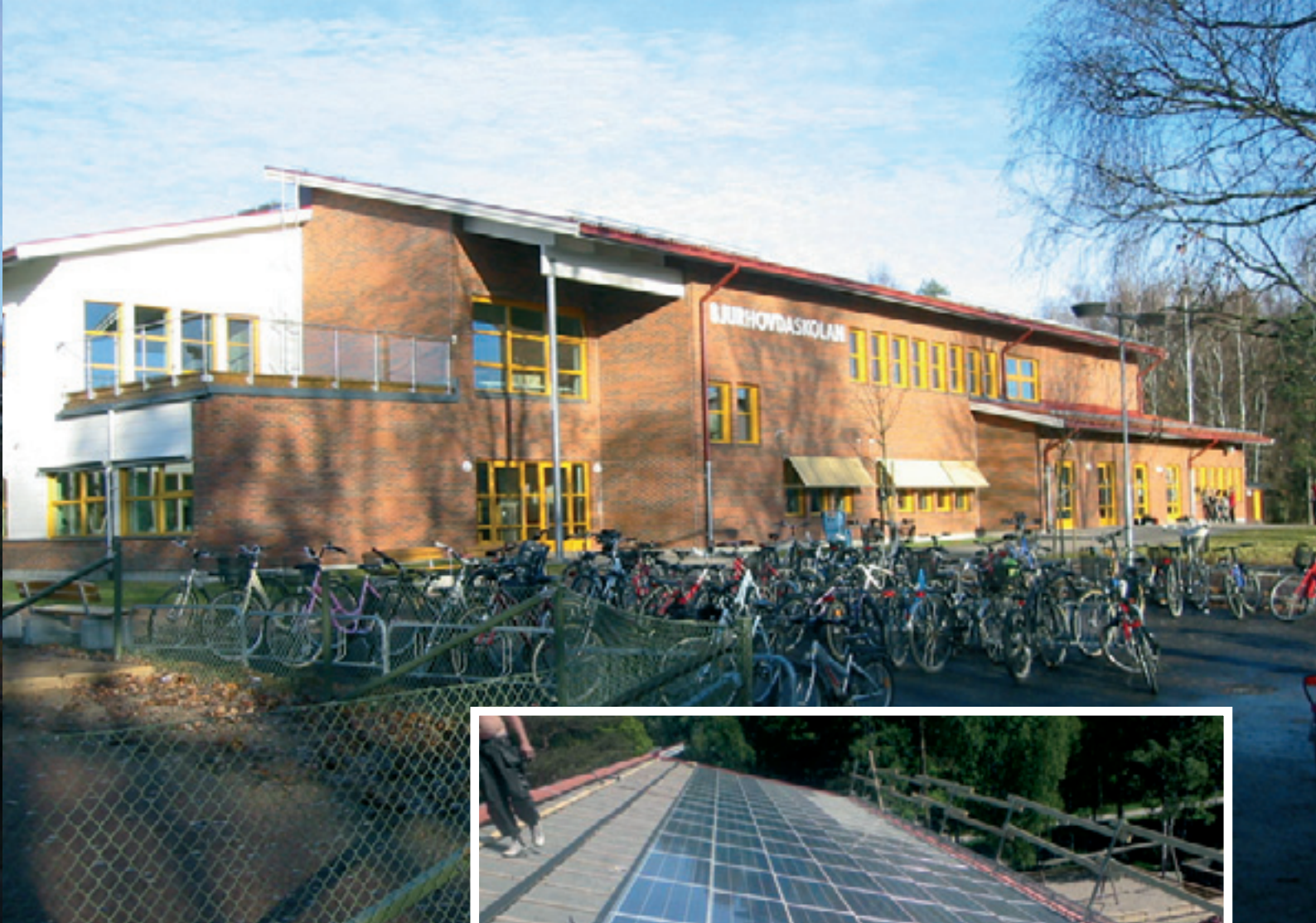
Den nya Bjurhovdaskolan har en av landets större solcellsanläggningar. Foto Tord Dahlen.
