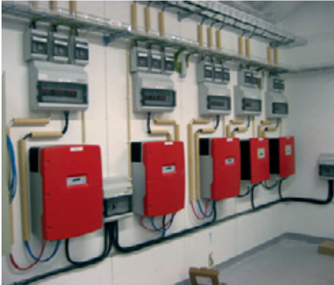
Elcentral och apparatrum. Foto NAPS
