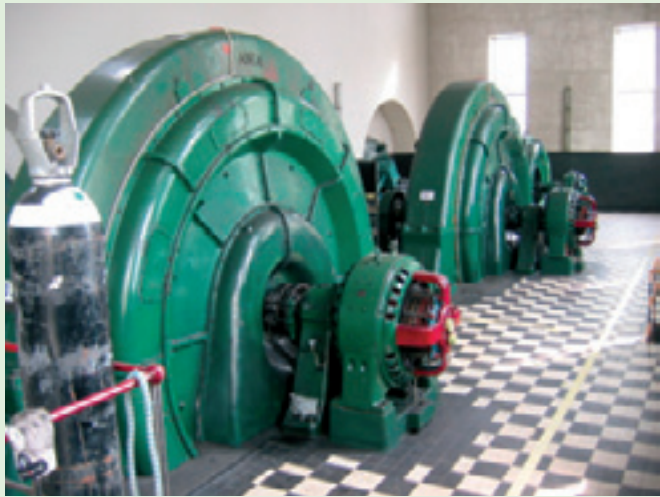
Ätrafors kraftstation där generatorerna är på 5+5+3 MW
