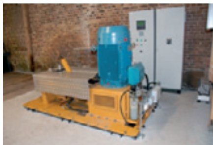
Cargo&krafts installation i Västra Kvarn, Ängelholm
