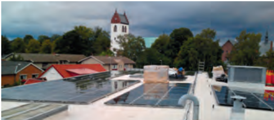
Solceller håller på att monteras på butikstaket i Hörby.
