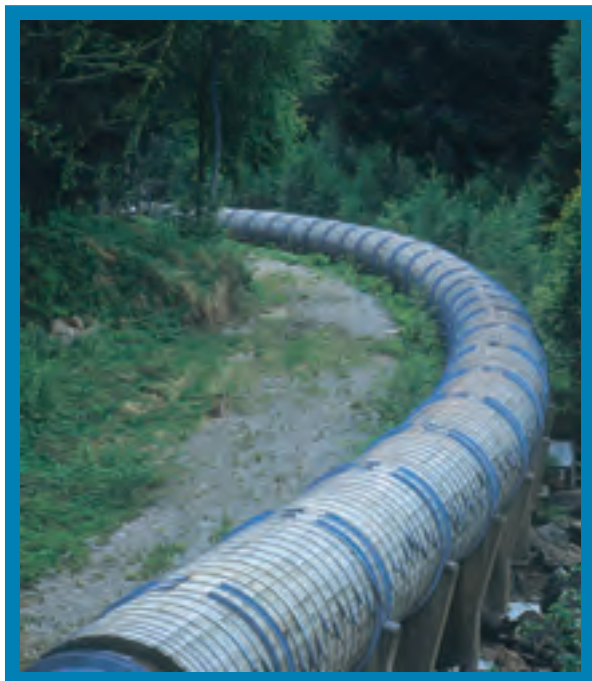
Kungfors kraftstation, Sandviken, turbinledning på fundament.
