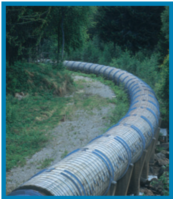
Kungfors kraftstation, Sandviken, turbinledning på fundament.
