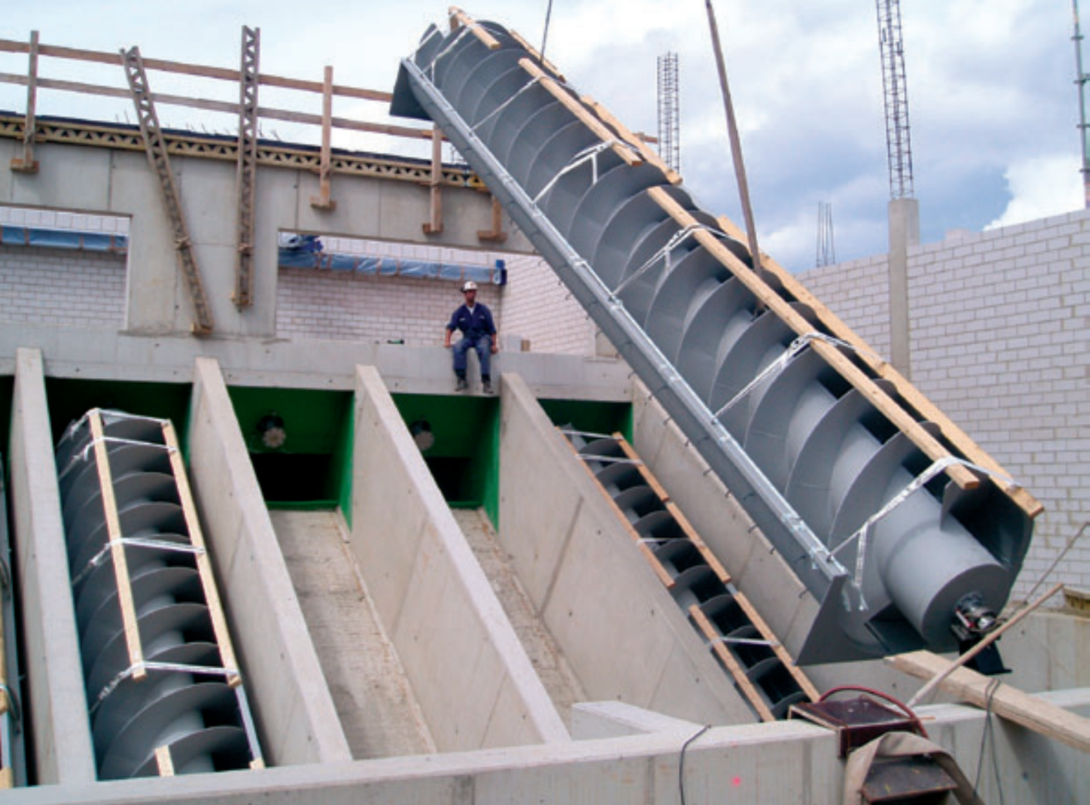
3 Arkimedesskruvar monteras parallellt i ett tyskt vattenkraftverk.
