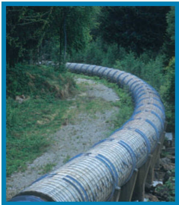
Kungfors kraftstation, Sandviken, turbinledning på fundament.
