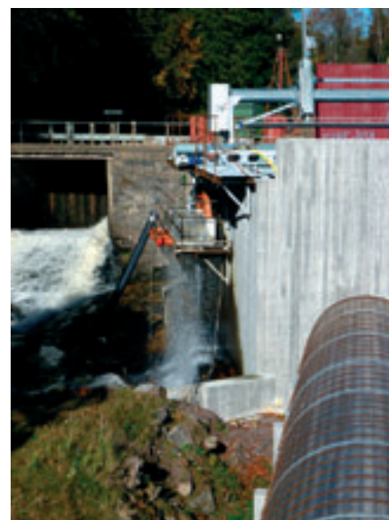
Alsters kraftverk i Värmland har flyktöppningar för ål och annan fisk. Foto: Olle Calles
