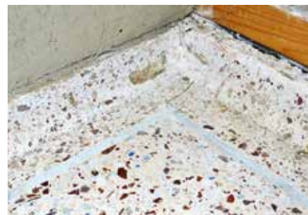
Badrumsgolv i terrazzobetong med 5 cm hög kant och mjuk fog för rörlighet.
