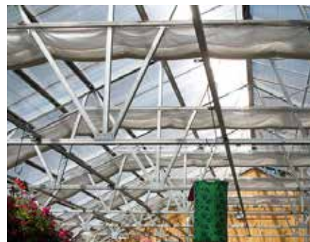
Energigardiner/energiväv i taket till ett växthus. Det är viktigt att inga springor finns uppåt för bästa funktion. Bild: United Greenhouse Systems.
